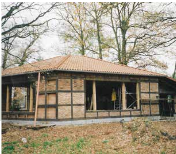
Bau des Pavillons.
