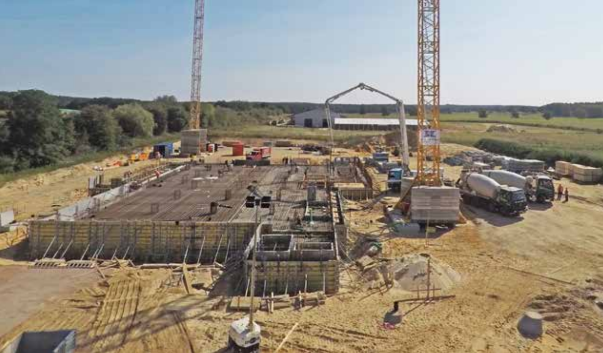
Die Bodenplatte des Mühlengebäudes wurde im August 2019 gegossen.
