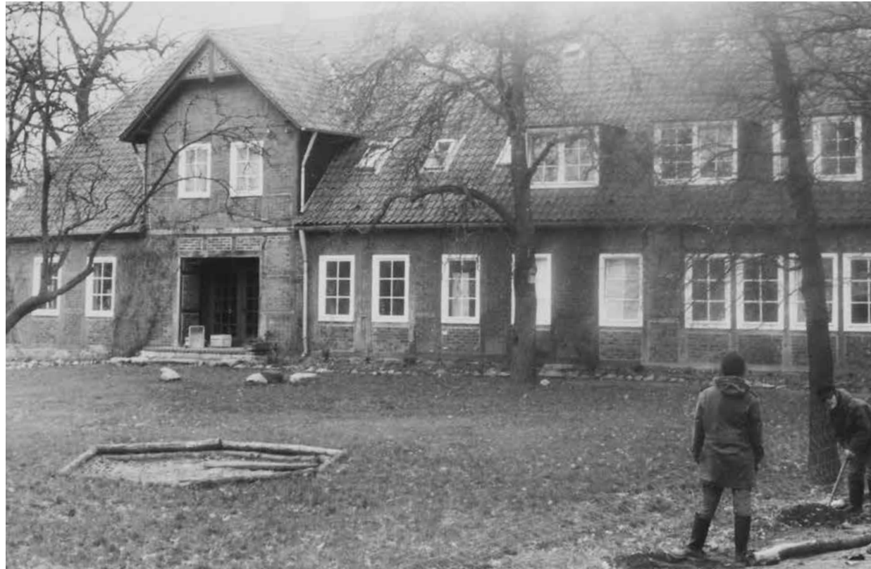
Der Eingang an der Rückseite ist heute der Übergang zum Saal.
