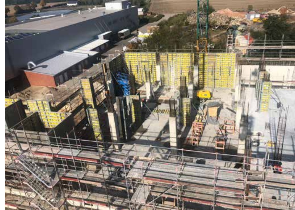
Zwei Monate später. Der Bau schreitet gut voran.
